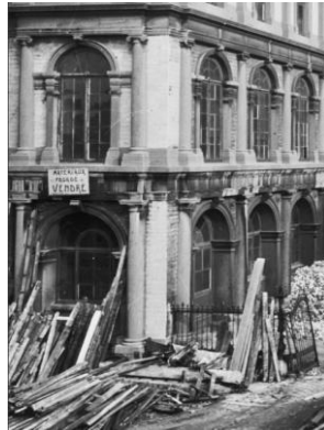
Démolition de l'ancien Palais Granvelle
