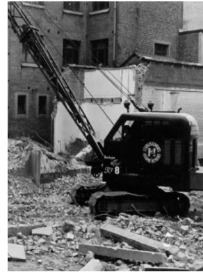
Pelle mécanique sur un chantier de démolition bruxellois
